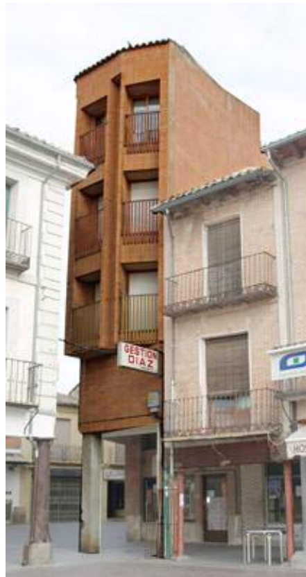
Inmueble nº 31 (fuera de ordenación)
